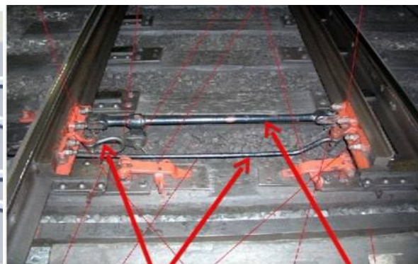
Рис. 2. Места, где возможен пробой изоляции
