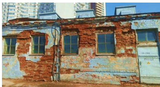
Рис. 1. Состояние подстанции
